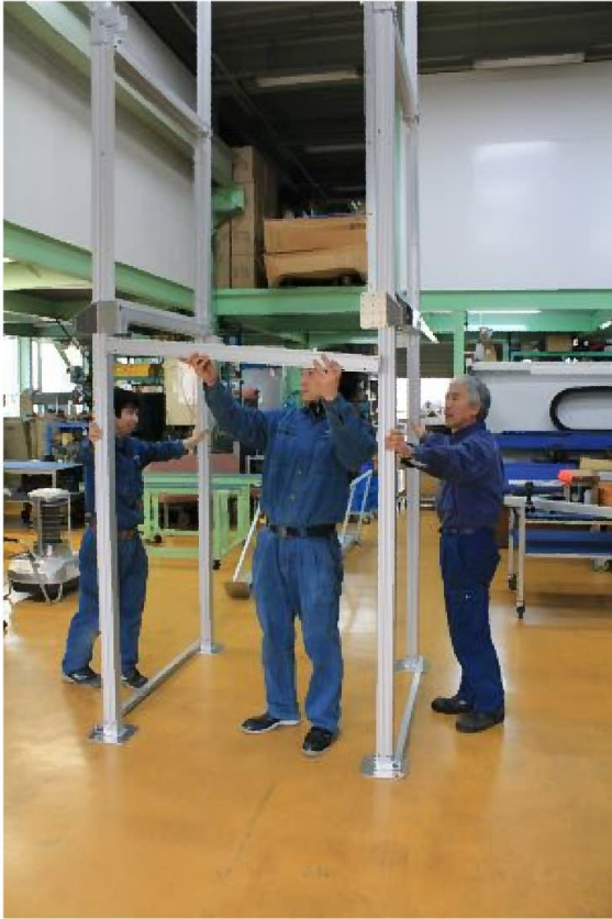
左右フレームを立て、間に連結フレームを取付ます。
