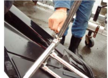
パイプの位置が決まったら 六角レンチで締めて固定します。
