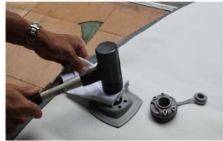
四角ベースの中央部分はウエス等で 当て布し保護してゴムハンマーで圧着
